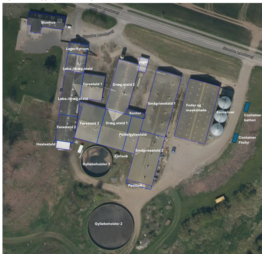
Figur 5. Anlægget på St. Bakkegård
